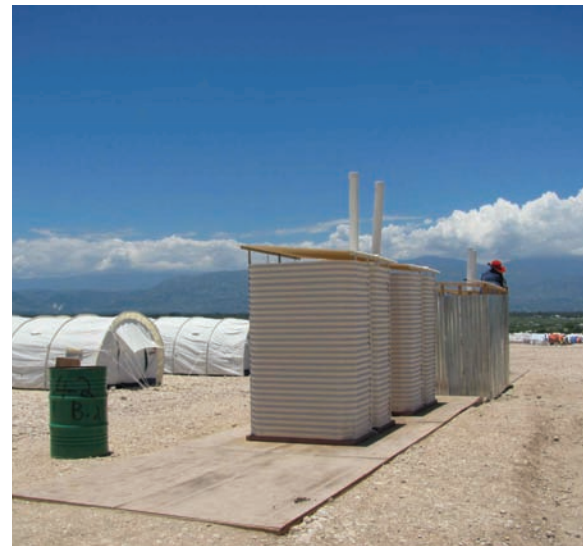
Camp Corail- Construction de latrines
